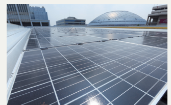
名古屋支店屋上
